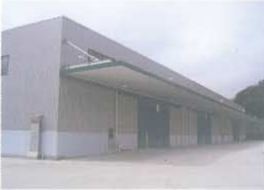
故紙・廃プラスチック処理工場
