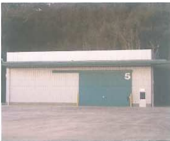
340㎡の非鉄倉庫。5mの庇で製品を雨水から守る工夫が施されている。
